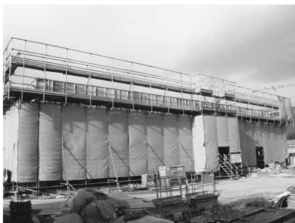
▲ 建設が進む商工会議所会館
