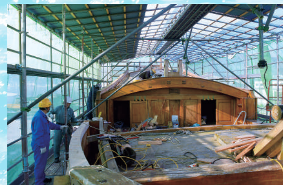
令和3年6月 陸揚げ展示に向けての補修作業開始
