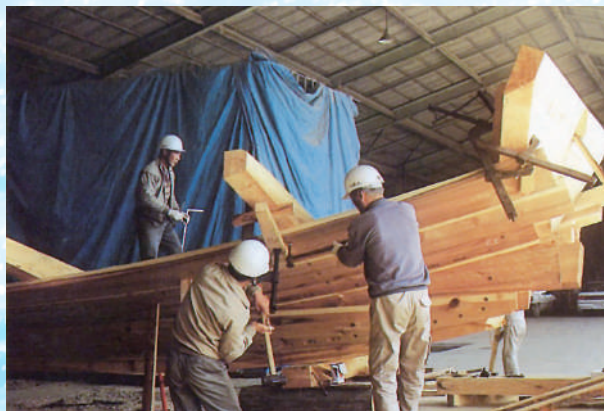
平成3年2月 着工
