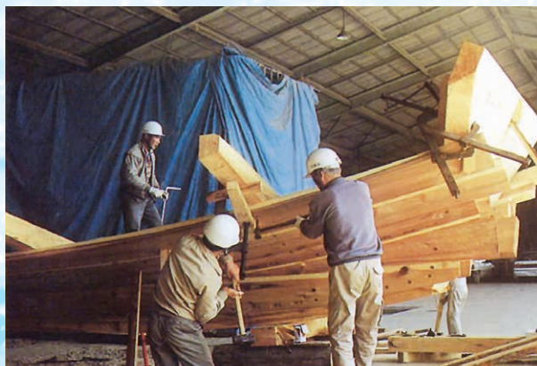
平成3年2月 着工
